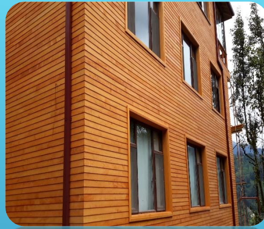
Dış Cephe Kaplaması
