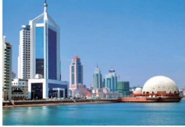
Deniz Suyu Kaynağının Kullanımı
